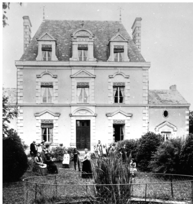
La villa " Margueritte " donne elle aussi sur le quai de la Noé. Elle fut construite vers 1858.
