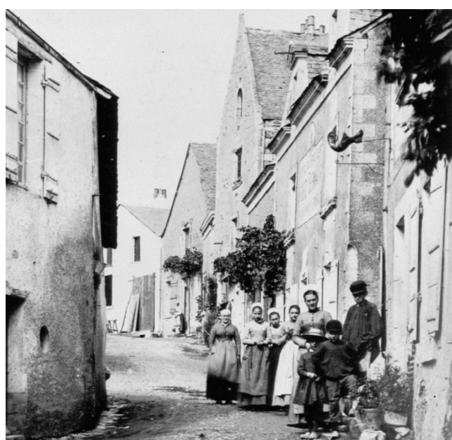
Rue de l'Ancien Port en 1891, aujourd'hui rue du Bac.
