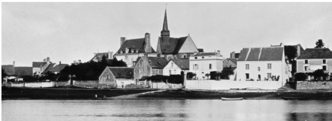
Bouchemaine bourg, vue d'ensemble du quai de la Noé à la fin du XIX e siècle, avec l'abbaye, l'église et la Maison Carrée avant travaux.
